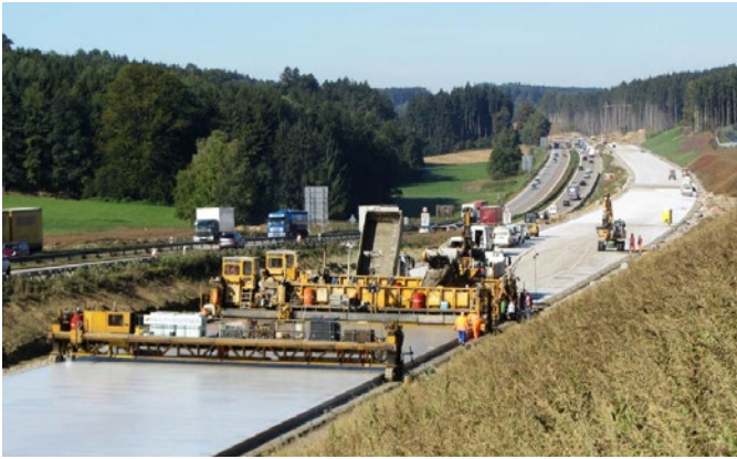
Устройство цементобетонного покрытия на новом участке автобана А8
