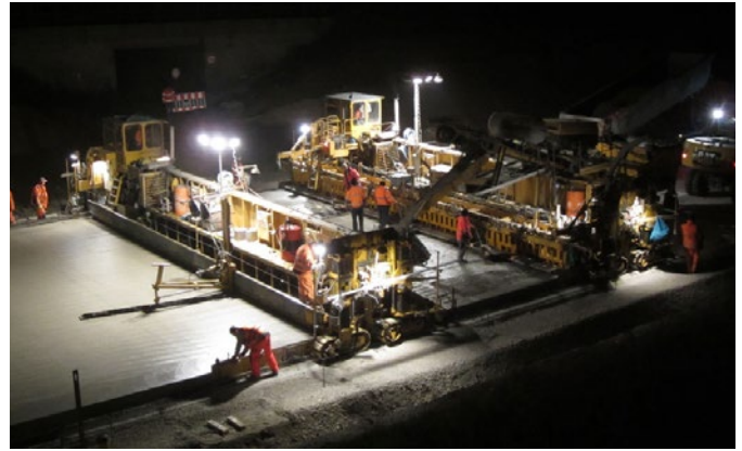
Бетонукладочные работы в ночное время суток
