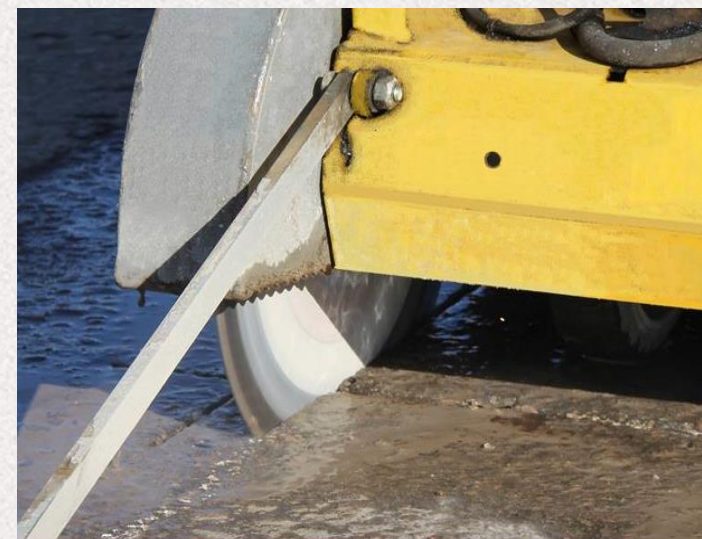
Резка покрытия шовнарезчиком
