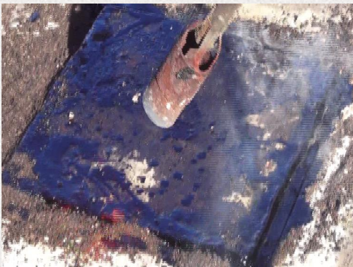
Укладка плитки и разогрев сопряжений горелкой
