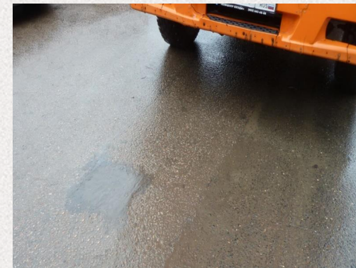
Ремонтная карта в процессе эксплуатации
