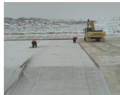
Изоляция швов матов
