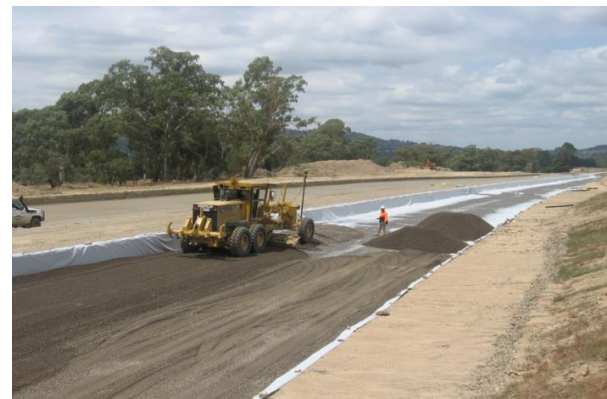
Гидроизоляция ядра насыпи с использованием бентонитового мата
