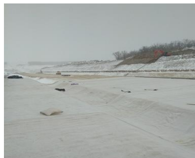
Изоляция водоотводной канавы
