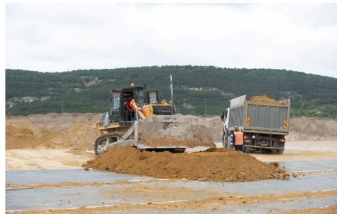
Применение бентонитового мата в конструкции гибкого ростверка при строительстве трассы «Таврида»
