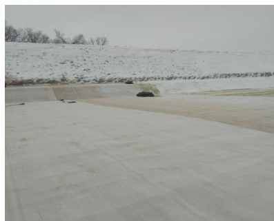
Изоляция земляного полотна
