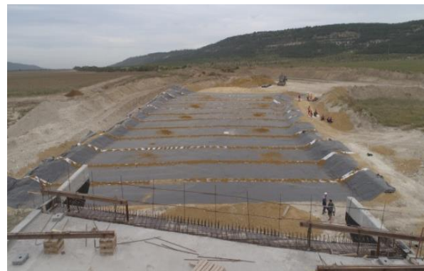
Применение бентонитового мата при строительстве трассы «Таврида»
