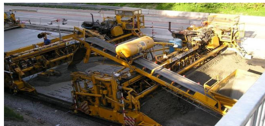
2-слойная укладка бетона
