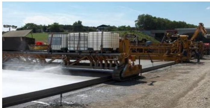
Нанесение комбинированного средства (замедлитель+кюринг)
