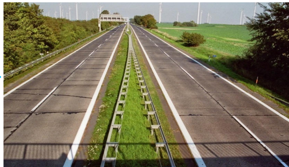
Участок автобана А11 Берлин - Штеттин с оригинальным ц/б покрытием (ок. 2010 г.)
