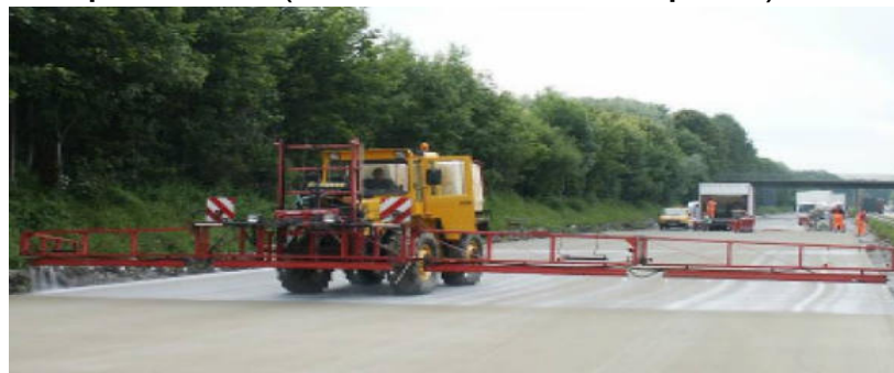
Нанесение кюринга (плёнкообразующего слоя)
