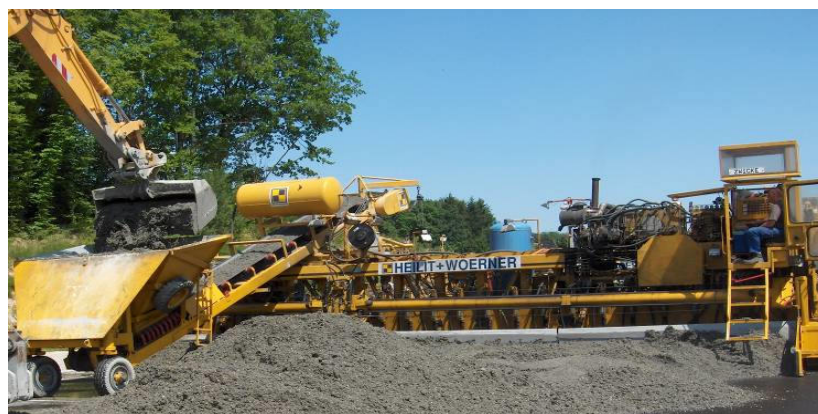
Разгрузка 2 сортов бетона
