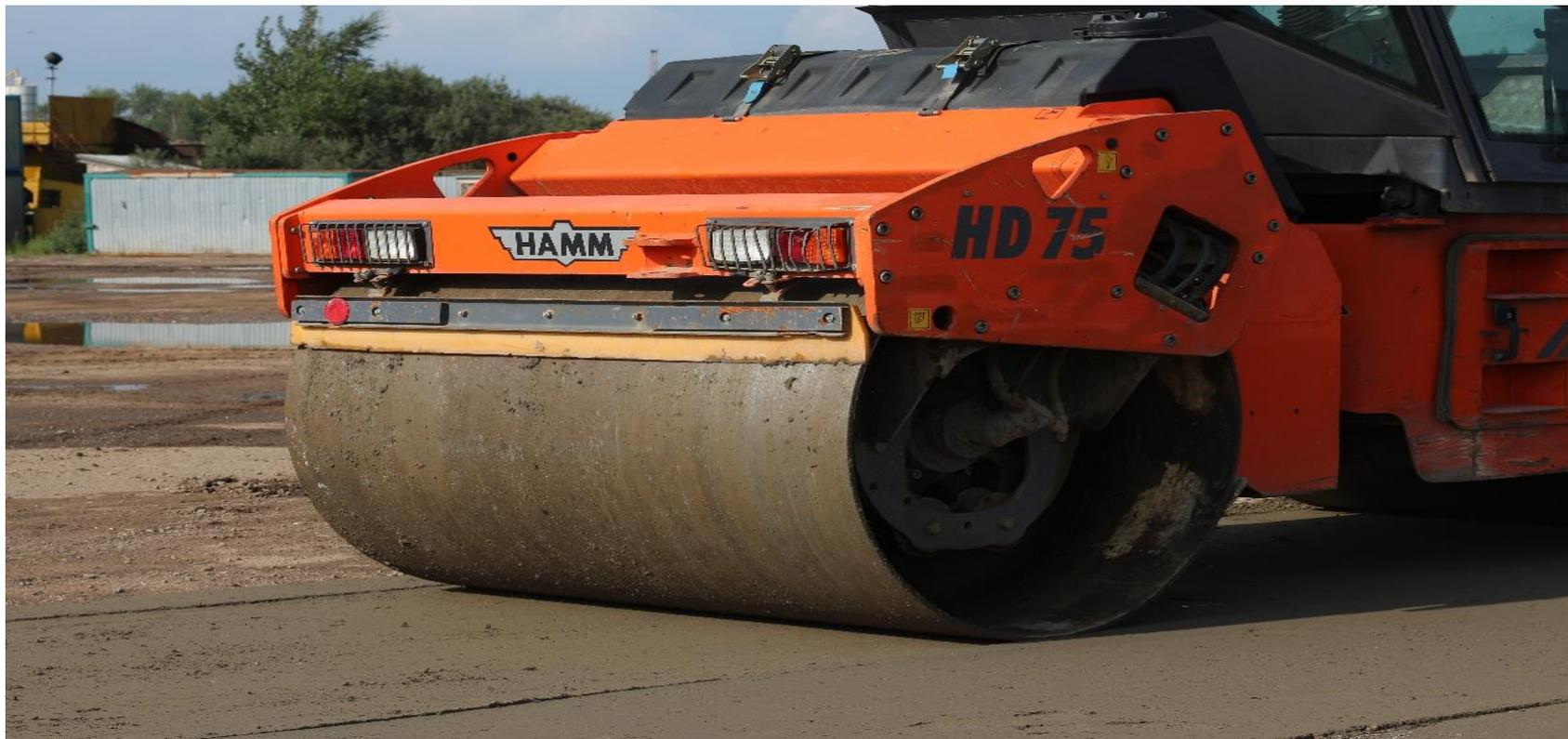
Распределенная и спрофилированная бетонная смесь должна немедленно уплотняться вибрационным катком
