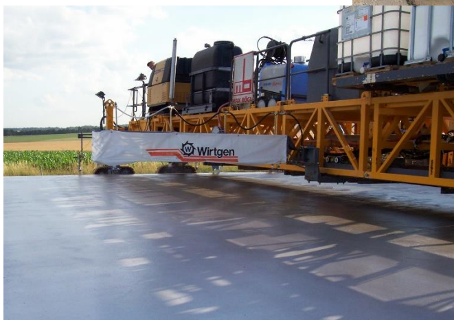
1-е: Распыление поверхностного замедлителя
