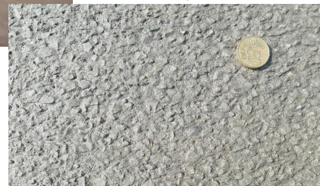
3-е: Поверхность с «открытым заполнителем» (глубина 1-2 мм) → после: нанесение плёнкообразующего состава
