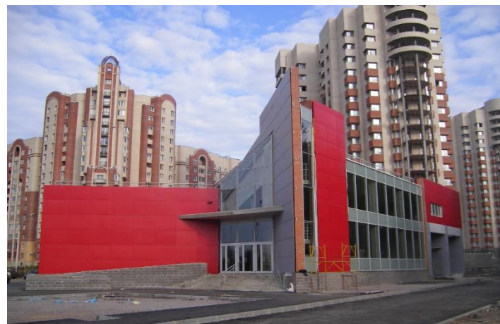
Здание торгового центра с вентилируемым фасадом из фиброцемента (Санкт-Петербург)
