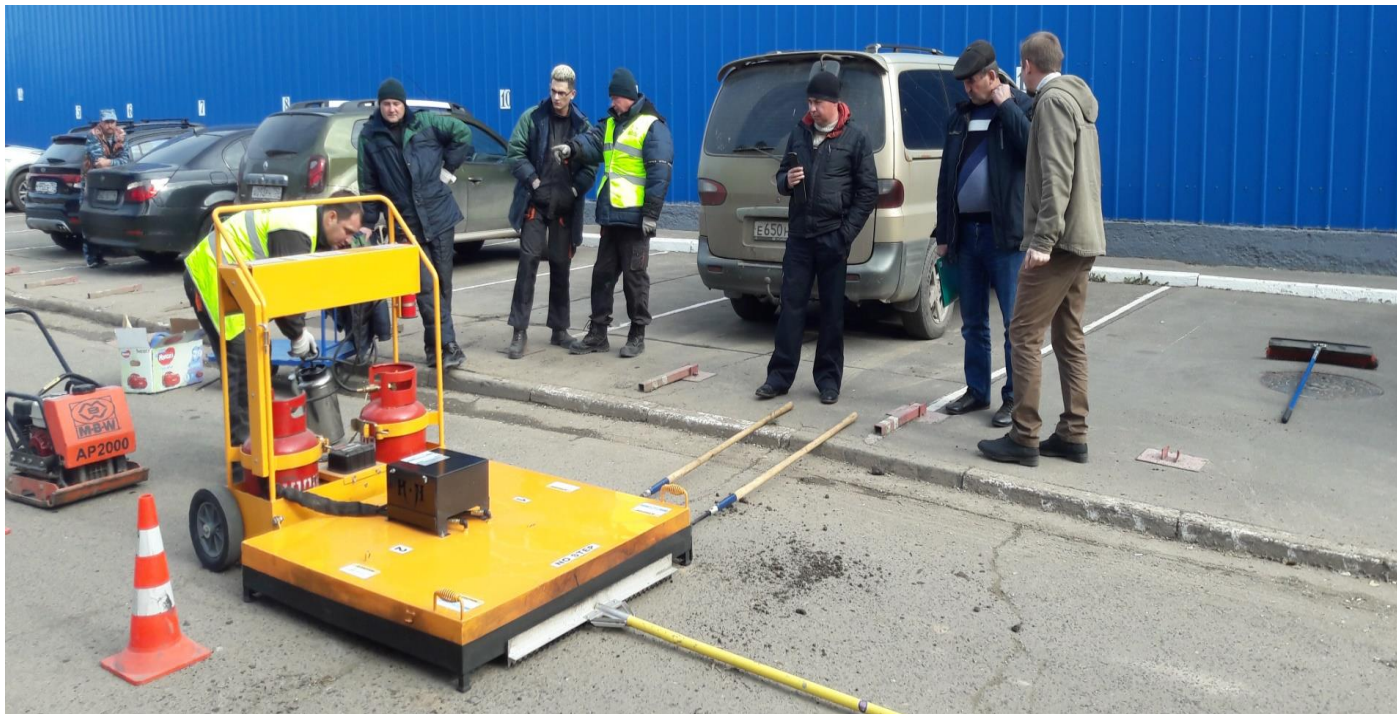
Ямочный ремонт с применением инфракрасного разогревателя
