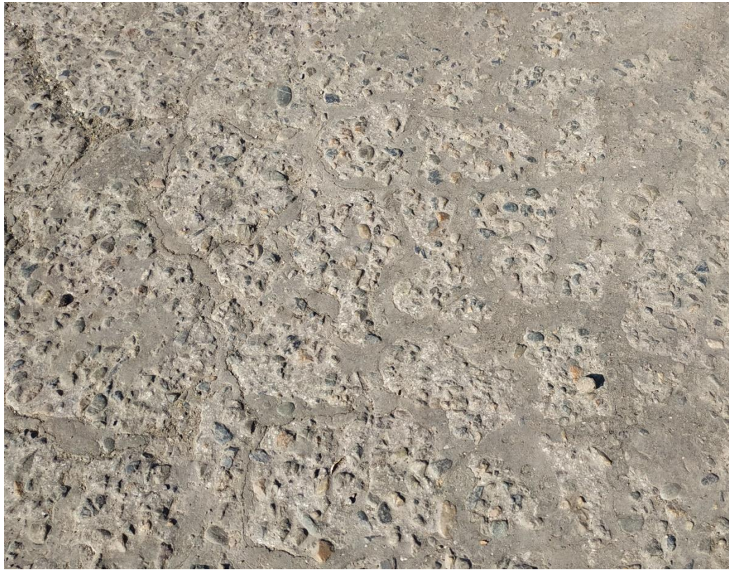
Через год после ремонта, 2019
