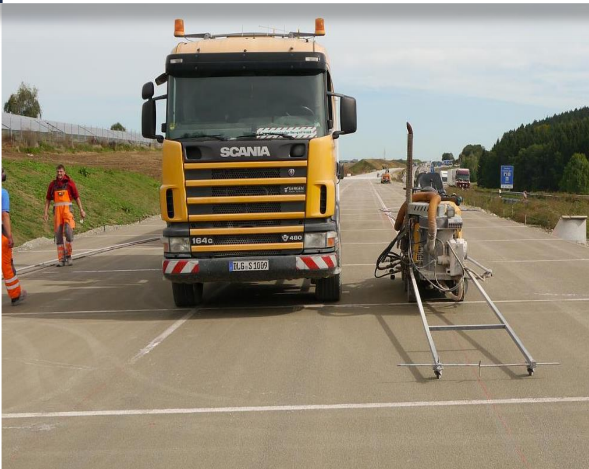
Нарезка деформационных швов
