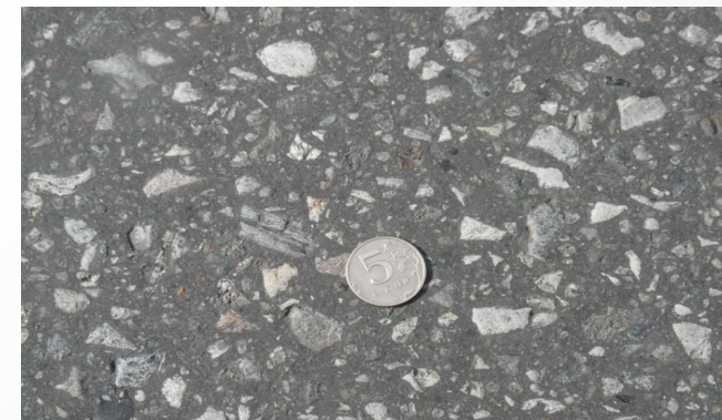
Состояние дорожного покрытия после 4 лет эксплуатации
