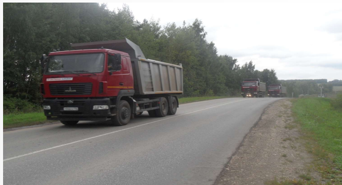
Состояние дорожного покрытия после 3 лет эксплуатации
