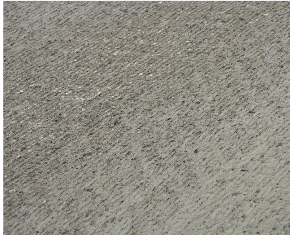
➤ Поверхность после фрезерования барабаном LA 6x2
