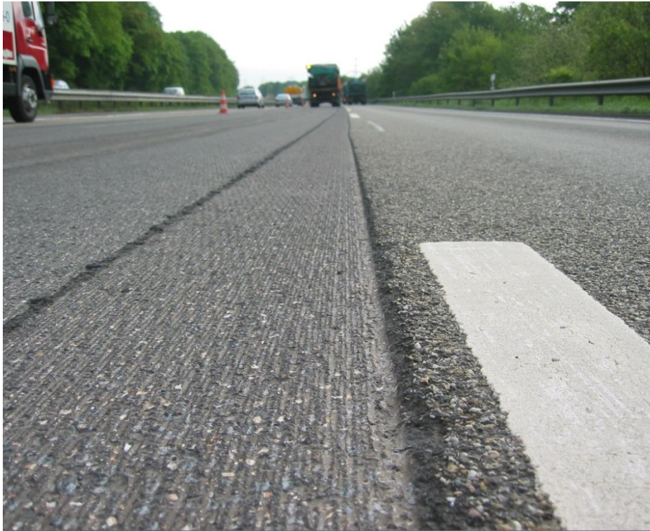
➤ Поверхность после / до фрезерования
