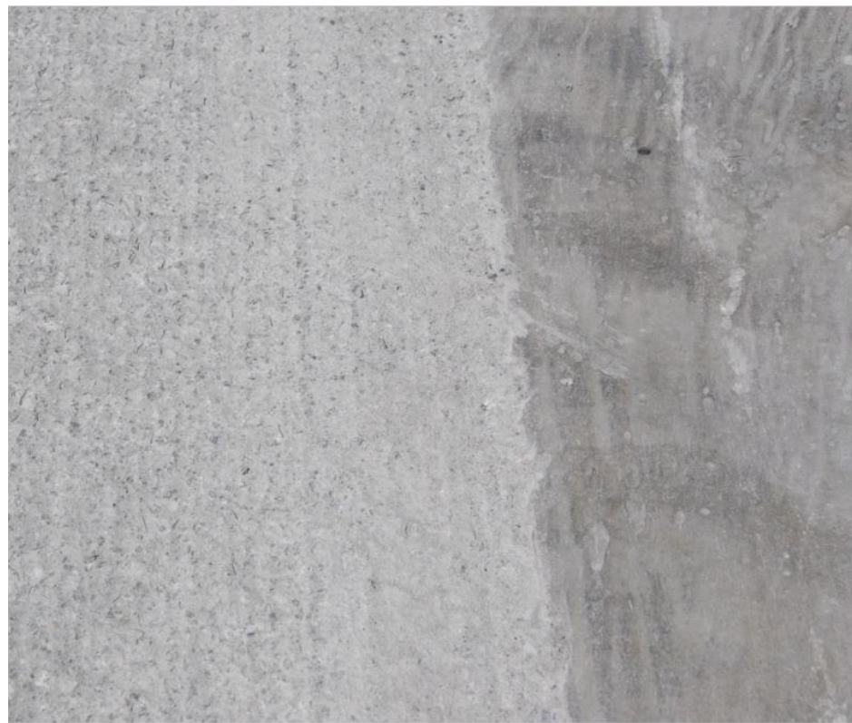
▶ Поверхность после/до фрезерования
