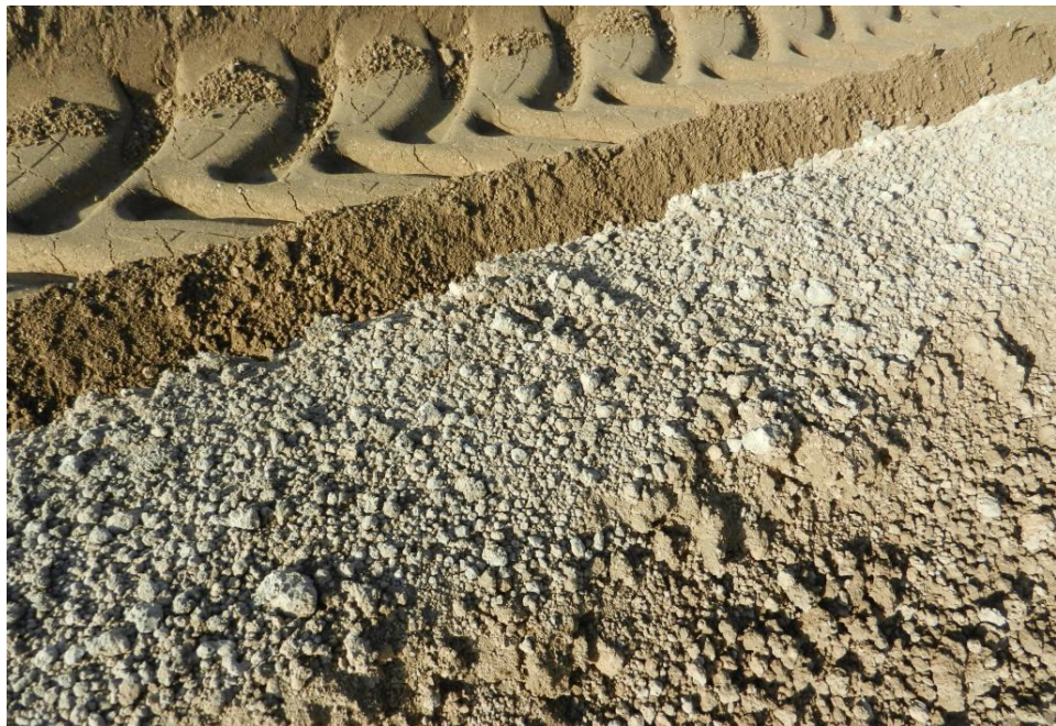
▶ Грунт после обработки вяжущим
