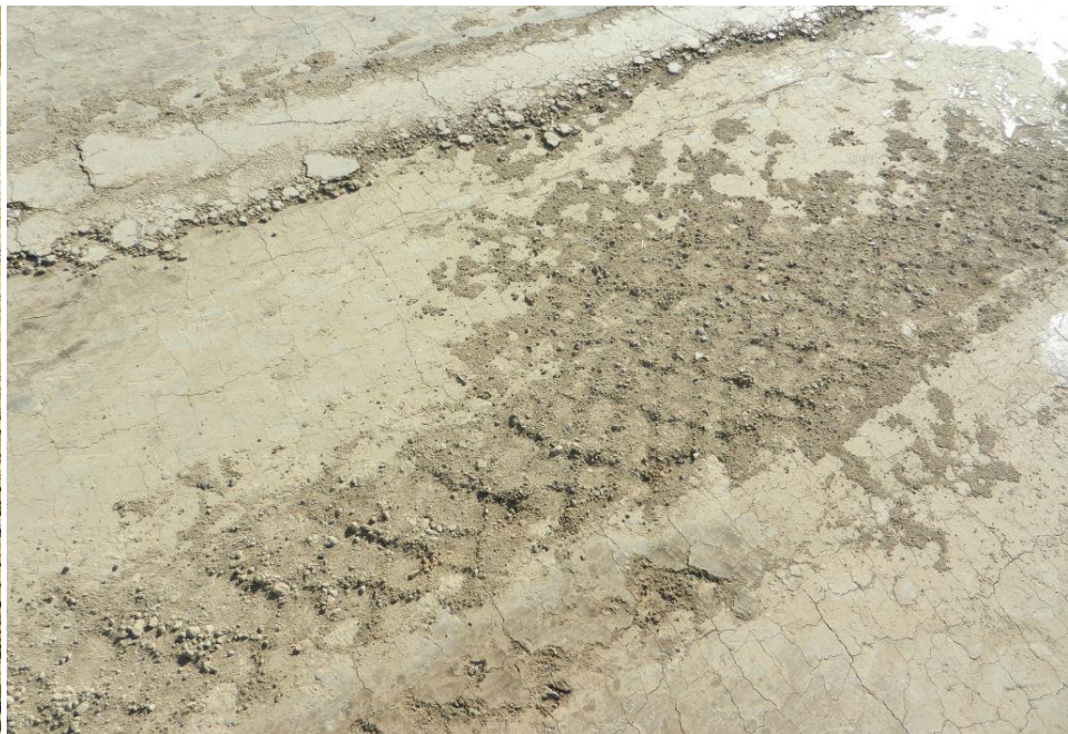
▶ Обработанный грунт после уплотнения
