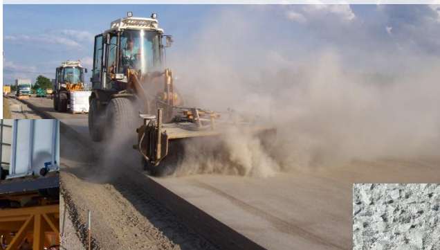
2-е: Выметание мелкого заполнителя
