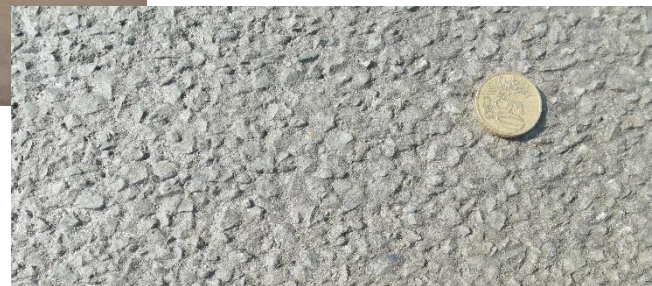
3-е: Поверхность с «открытым заполнителем» (Глубина 1-2 мм) → после: нанесение плёнкообразующего
