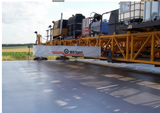
1-е: Распыление поверхностного замедлителя
