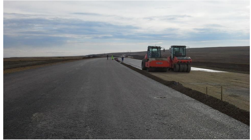
Геодезические работы и подготовка техники
