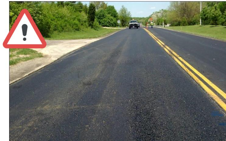
Температура слоя при уплотнении должна быть равномерной.
