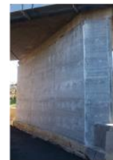
Защита и усиление опор
