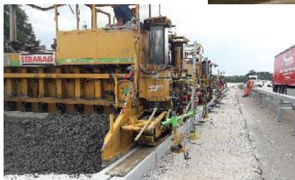
Традиционное цементобетонное основание
