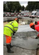
Гидроизоляция и ремонт плит проезжей части
