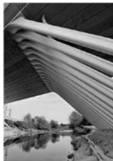
Сваи и элементы опор
