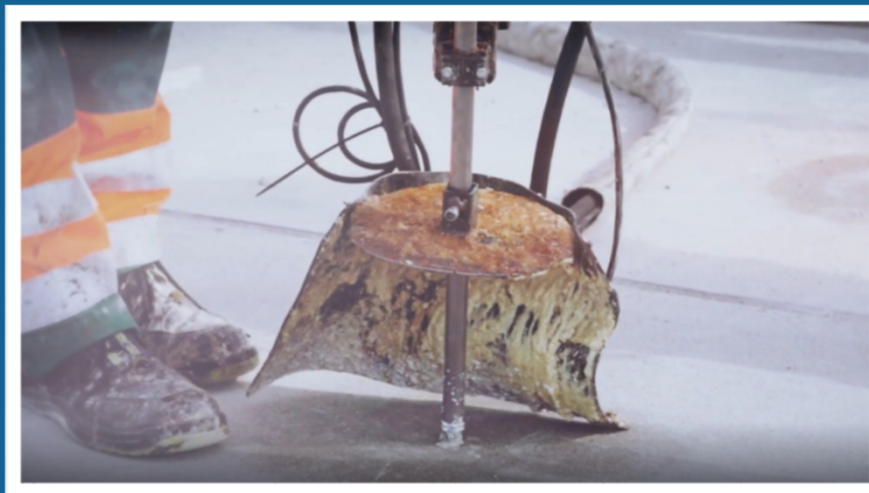
СВЕРЛЕНИЕ СКВОЗНЫХ ОТВЕРСТИЙ
