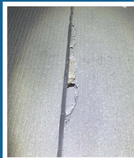
Скол кромки покрытия
