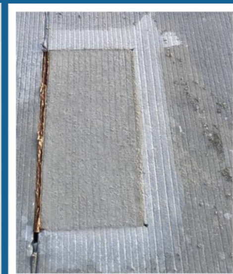
Скол кромки покрытия
