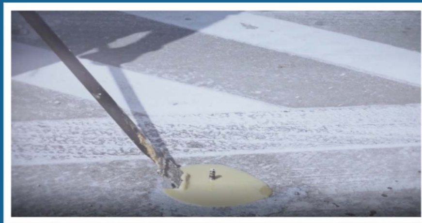
Заполнение отверстий специальным составом
