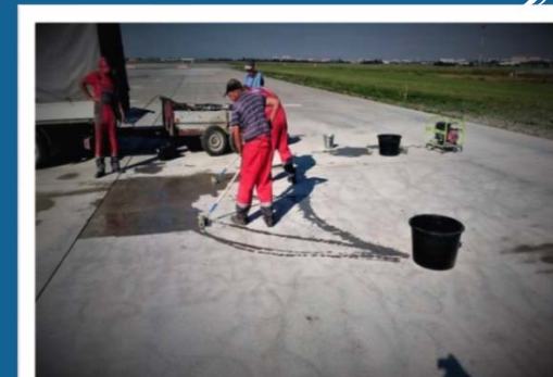
Гидрофобизация, обработка упрочняющими составами
