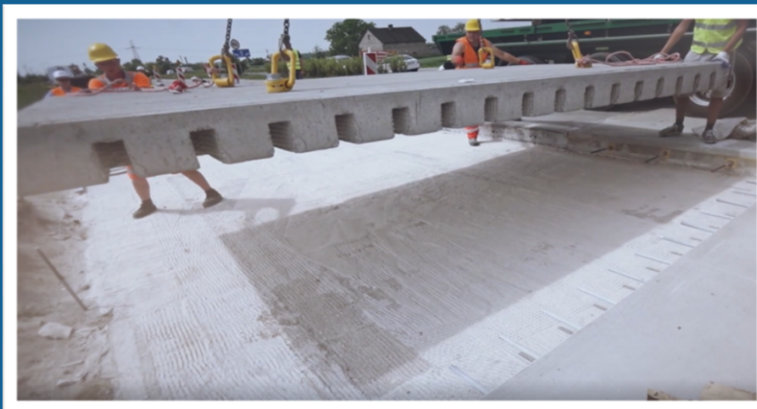
Монтаж в проектное положение
