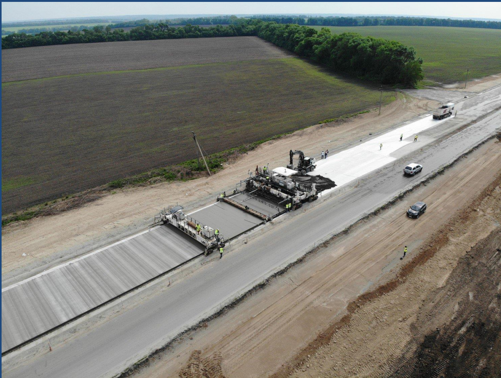
Укладка основного слоя бетона на автодороге Н-31 в Кобелякском районе (Украина)
