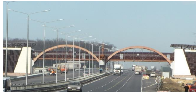
Арки пролетных строений из клееного бруса
