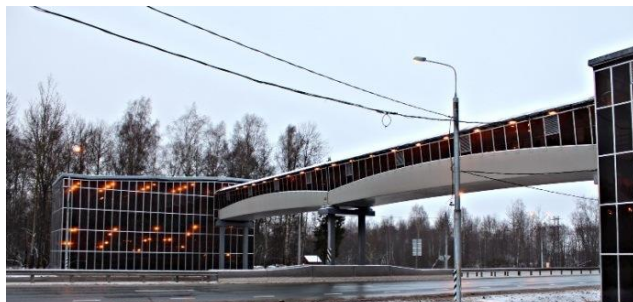
Монолитные цельнокомпозитные конструкции пролетных строений
